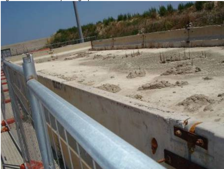
Figura 3 – Vasca di deposito già presente nelle aree di banchina
