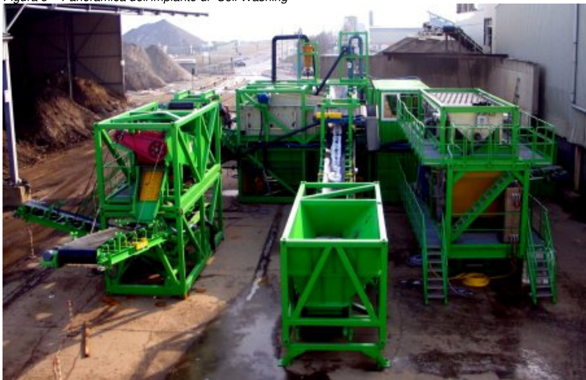
Figura 5 – Panoramica dell'impianto di "Soil Washing"
