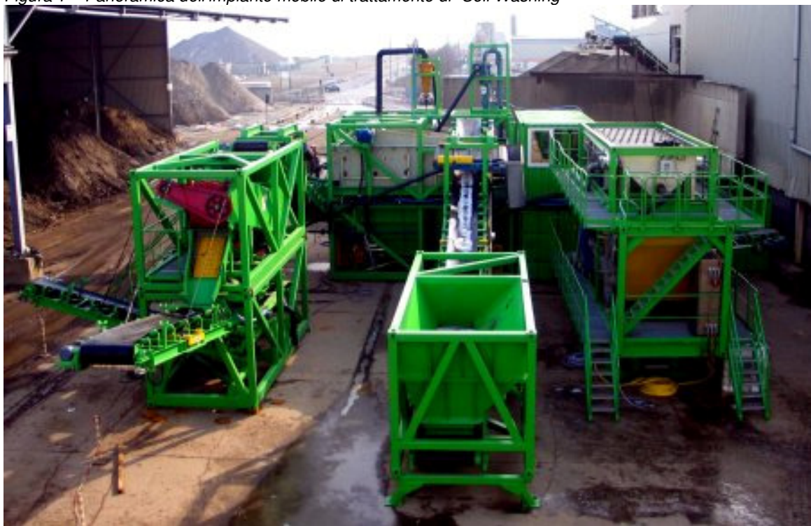
Figura 1 – Panoramica dell'impianto mobile di trattamento di "Soil Washing"
